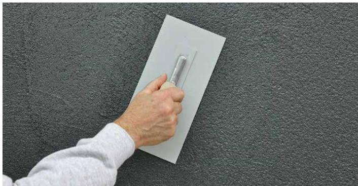
Abreiben eines Putzes
