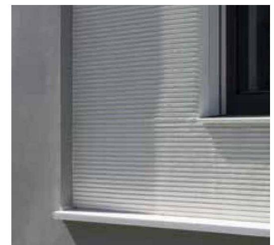
Wohngebäude in Ludwigshafen mit besonderer Detailausbildung um die Loggien
