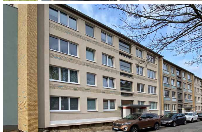
Sensible Sanierung und Neuinterpretation: Wohnbauzeile vor und nach der Instandsetzung
