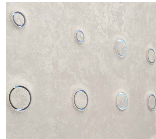
Durch integrierte Sensoren kann die Putzfassade neue Funktionen übernehmen und zu einem Teil des Netzwerks werden
