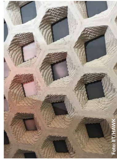
Durch automatisierte Fertigungsprozesse erreicht die Putzfassade eine dritte Dimension
