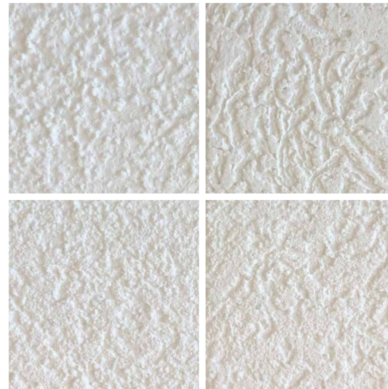
Oberflächengestaltung durch unterschiedliche Putzstrukturen
